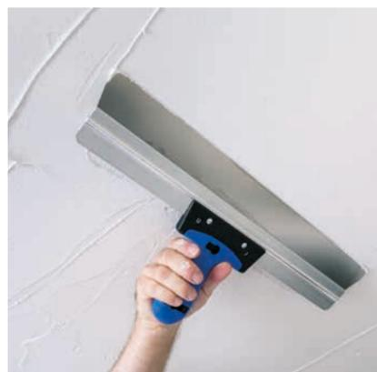
Damit das Baumit IonitSystem die ideale Wirkung erzielt, sollten ein paar Verarbeitungshinweise berücksichtigt werden. Es kann auf nahezu allen gängigen Untergründen angewendet werden, sofern diese trocken, sauber und tragfähig sind. Dies gilt sowohl im Neubau, als auch in der Renovierung.
